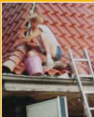
Der Chef legte bei der Restaurierung des Kiosks überall selbst Hand an. Fotoquelle: Klaus Erdmann (Restaurierung und Public Viewing)
